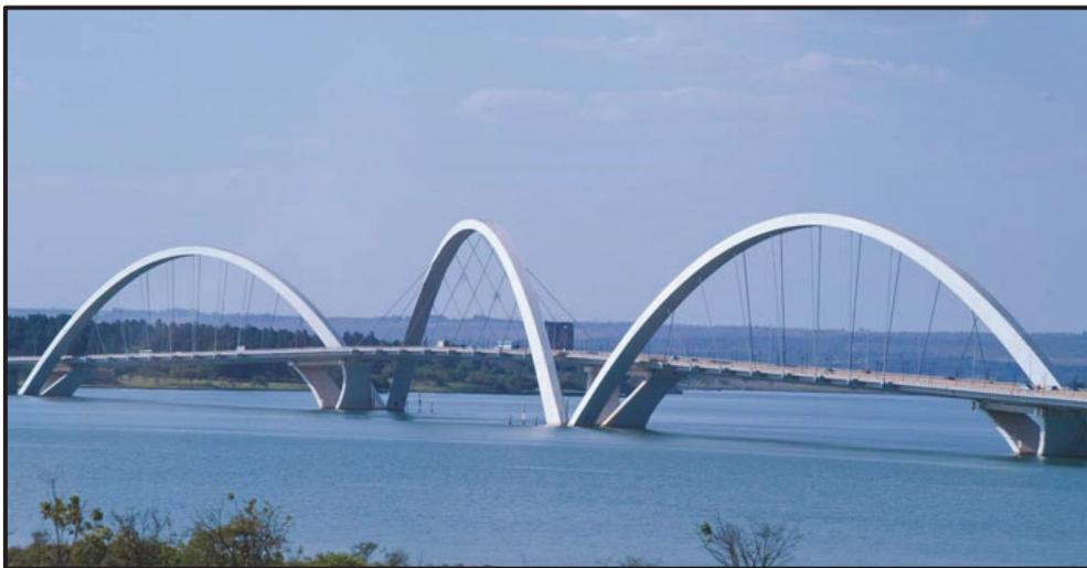
**Figura 14:** Ponte Juscelino Kubitschek (Ponte JK) sobre o Lago Paranoá em Brasília, construída com liga de ferro-nióbio
